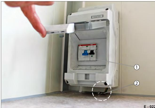
**Abb. 24** Stromverteilerkasten
