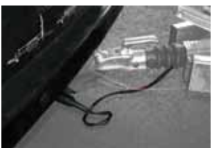
Bild: Stromversorgung anschließen
